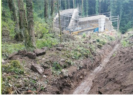
Avec l'autorisation de la DDT 88 nous avons réalisé le désensablement du Mureau pour faire réapparaître les murs de l'ancien canal. Mickaël de TERRA VOSGES a réalisé avec brio ce travail.
