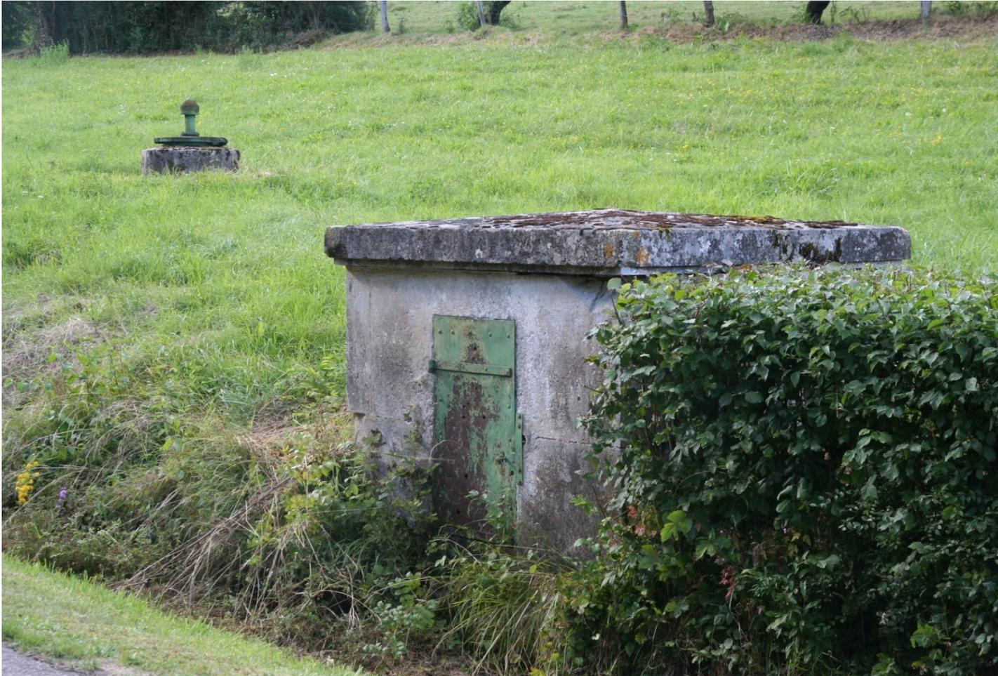
L'eau descend par gravité jusqu'à la station de pompage. Il est prévu une quantité d'eau de 18m<sup>3</sup>. Le débit de la source a été évalué à 86 m<sup>3</sup> par jour.
